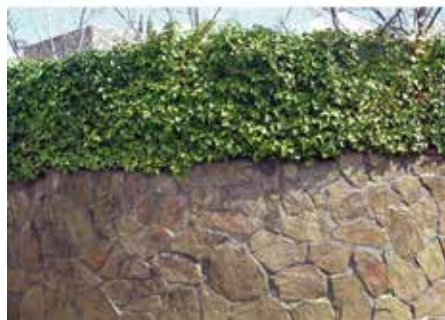
Un muro, antes y después de su limpieza.
